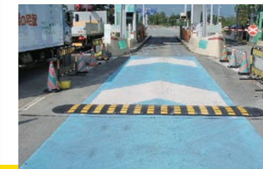
ETCレーンにも採用されています。
