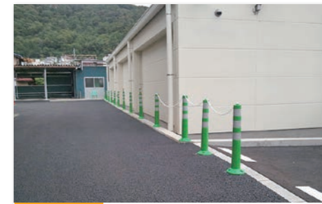
山梨県 ファミリーマート隣地境界工事 様
